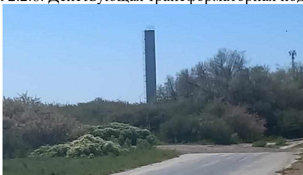
Рисунок 2.2.9. Локальное водозаборное сооружение.
