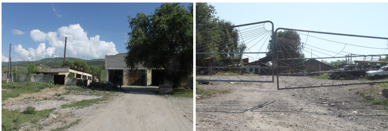
Рис.6.4.6 Заброшенные производственные предприятия
