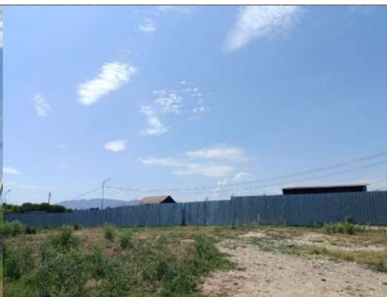
Новая водозаборная насосная станция
