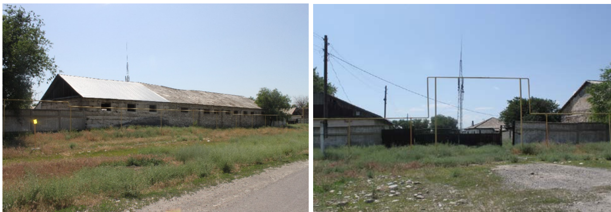
Рис.6.2.7 Территория производственной зоны
