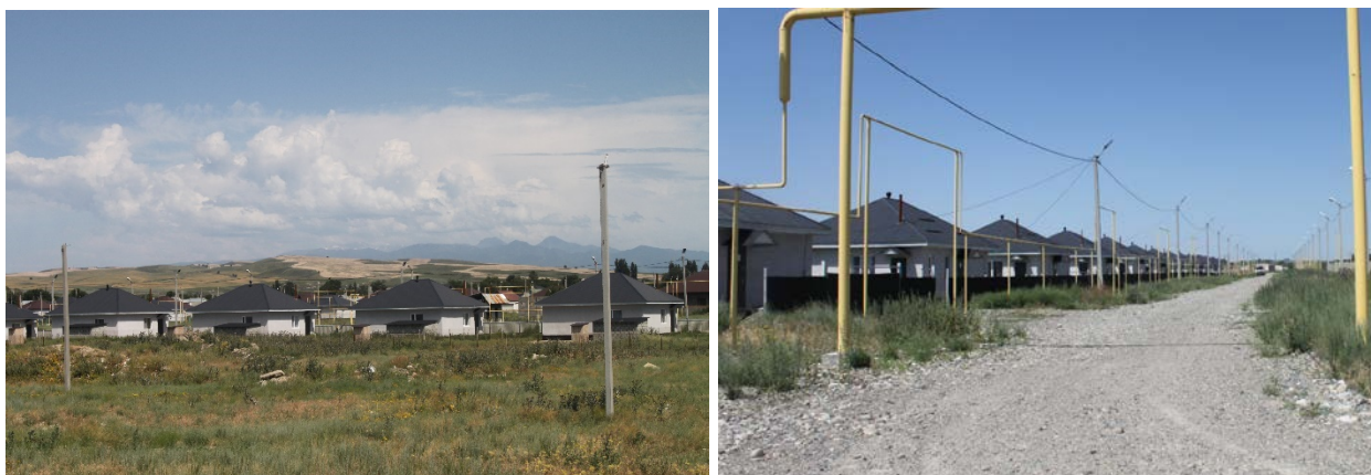
Рис.6.2.4 Коттеджная застройка в западной части села
